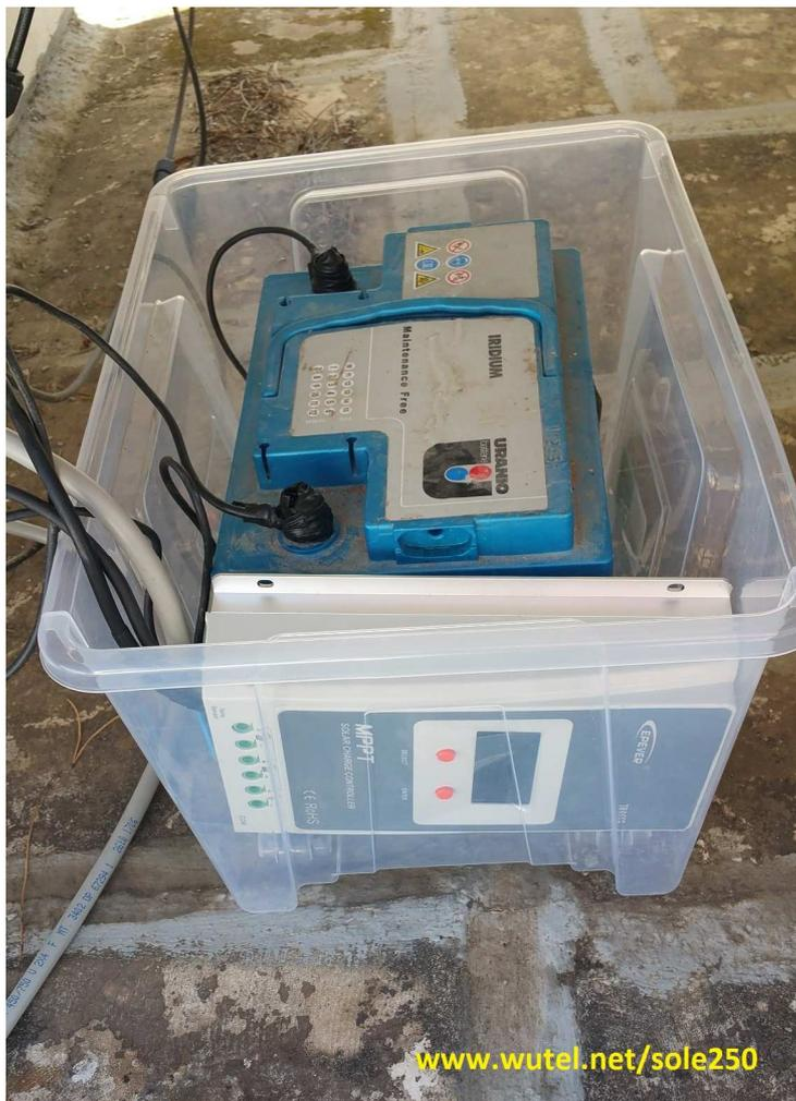
**⚠** Il collegamento dei cavi elettrici ai poli della batteria, è stato sistemato definitivamente, in maniera più sicura e appropriata, nei giorni successivi alla messa in funzione dell'impianto, tramite idonei morsetti reperiti in un negozio di accessori per auto:
