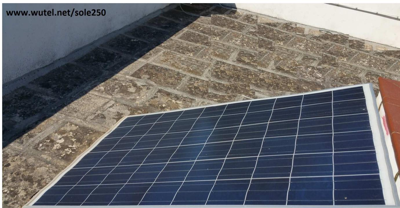
il fissaggio del pannello è stato effettuato tramite delle staffe a "L", tassellate al parapetto perimetrale in muratura.
