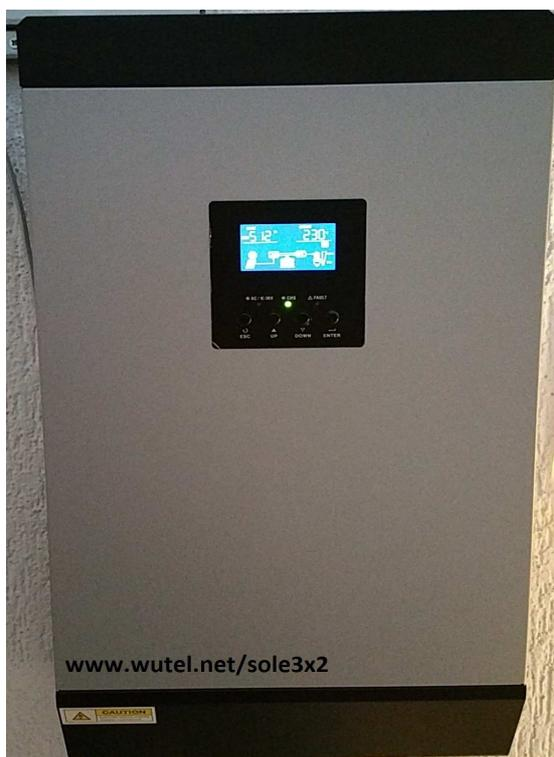
Il modello di inverter utilizzato in questo impianto è quello da 4000Watt di potenza, con regolatore di carica da 60Ampere, che utilizza l'innovativa tecnologia di ricarica "MPPT".
