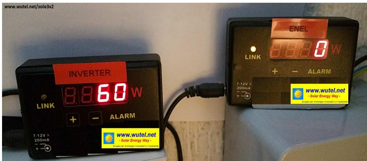
Inoltre, è stato anche installato in ciascuno degli appartamenti, un totalizzatore per la contabilizzazione dei kWh (kilowattora) consumati da ciascuna famiglia, posizionato nei rispettivi quadri elettrici di distribuzione (ubicati nei due alloggi), al fine di poter correttamente ripartire le spese di consumo elettrico in bolletta, in base agli effettivi kWh consumati.
