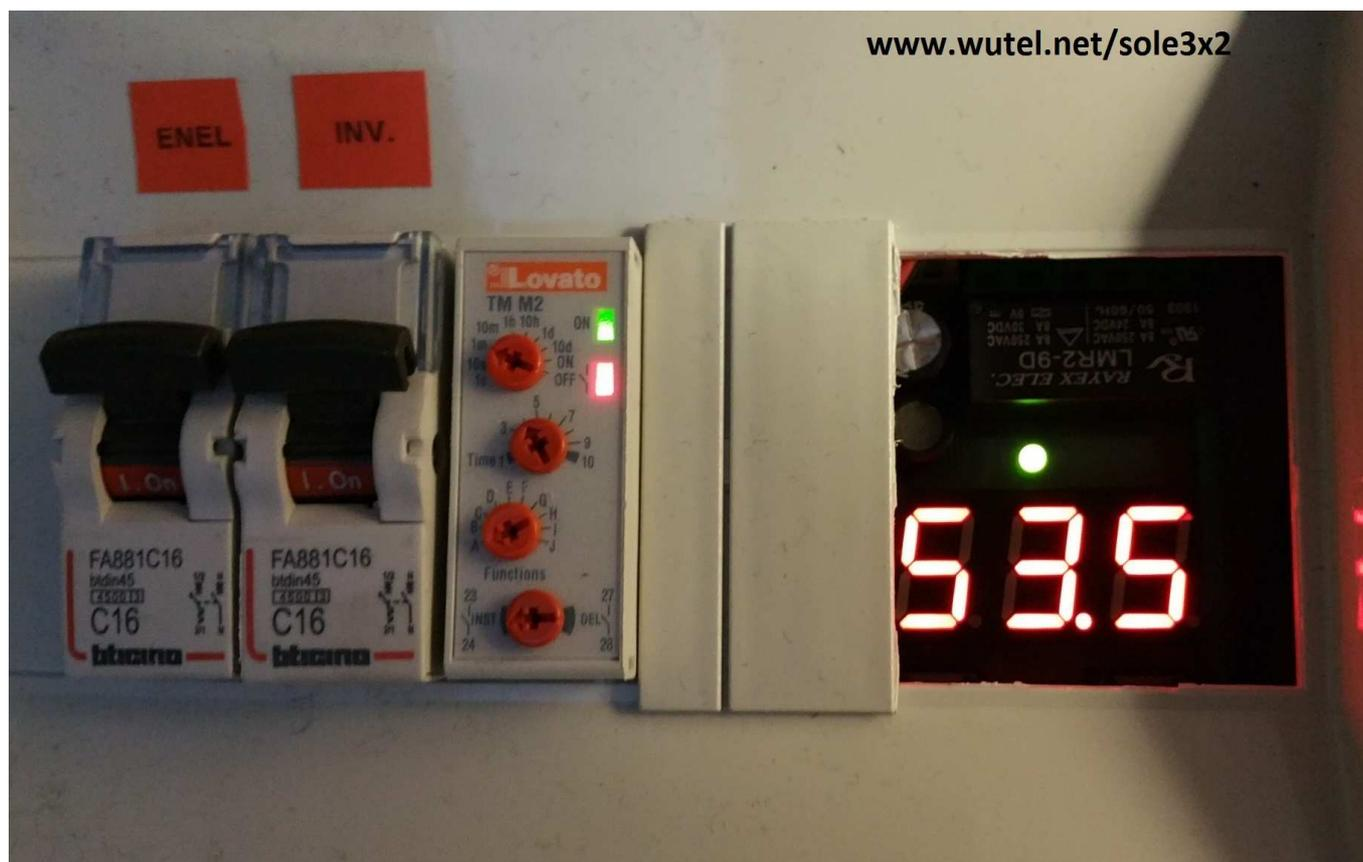
La commutazione automatica tra l'inverter e la rete ENEL evita di prelevare energia elettrica a pagamento (da ENEL o altri fornitori), fino a quando il sole e le
