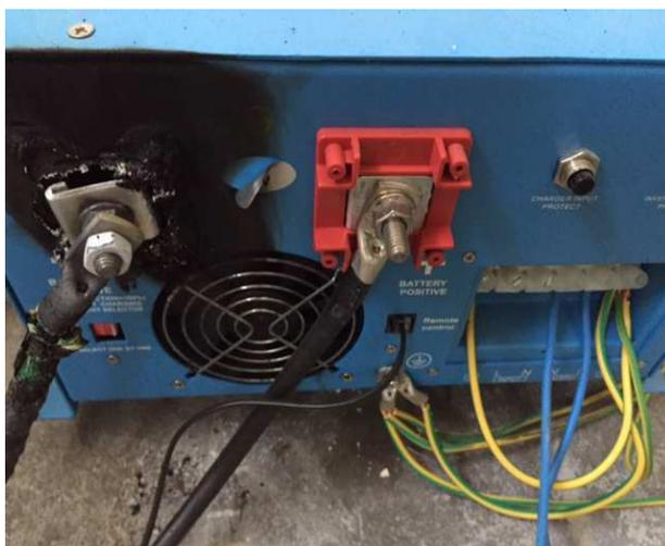
Nella foto qui sopra, il capocorda di destra è stato correttamente montato e la superficie di contatto risulta perfettamente aderente alla piastra di contatto del morsetto (+) dell'inverter.
