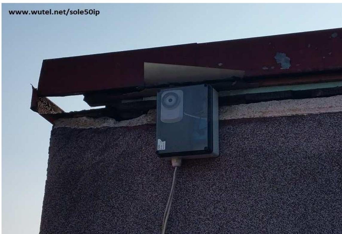
La telecamera IP utilizzata in questo impianto ha la particolarità di poter essere collegata a internet in modalità senza fili (wireless) WiFi 2,4GHz, oppure tramite cavo di rete LAN, intestato con un normale connettore standard tipo "[RJ45](#)".
