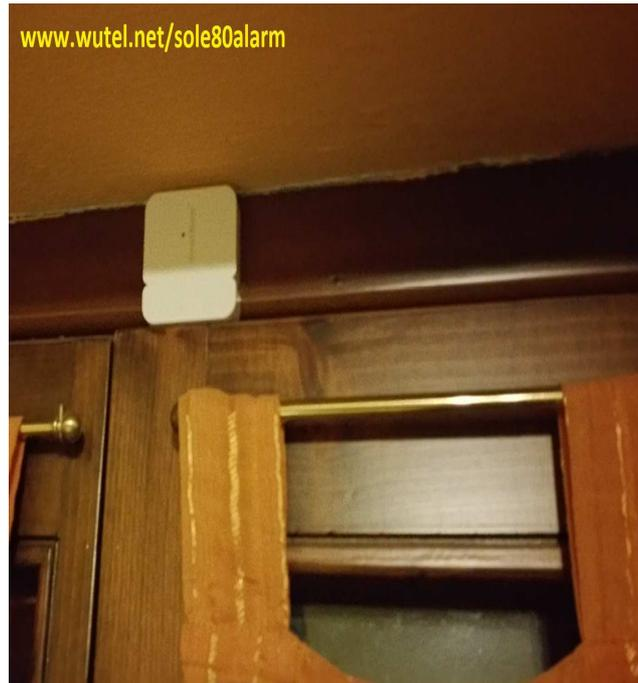
i sensori antintrusione con tecnologia a contatto magnetico, oppure quelli di movimento "PIR", dialogano con la centralina d'allarme tramite onde radio nella gamma di frequenza UHF e sono alimentati autonomamente da pile contenute al loro interno, quindi non necessitano di alcun cavo elettrico per il collegamento nell'impianto.
