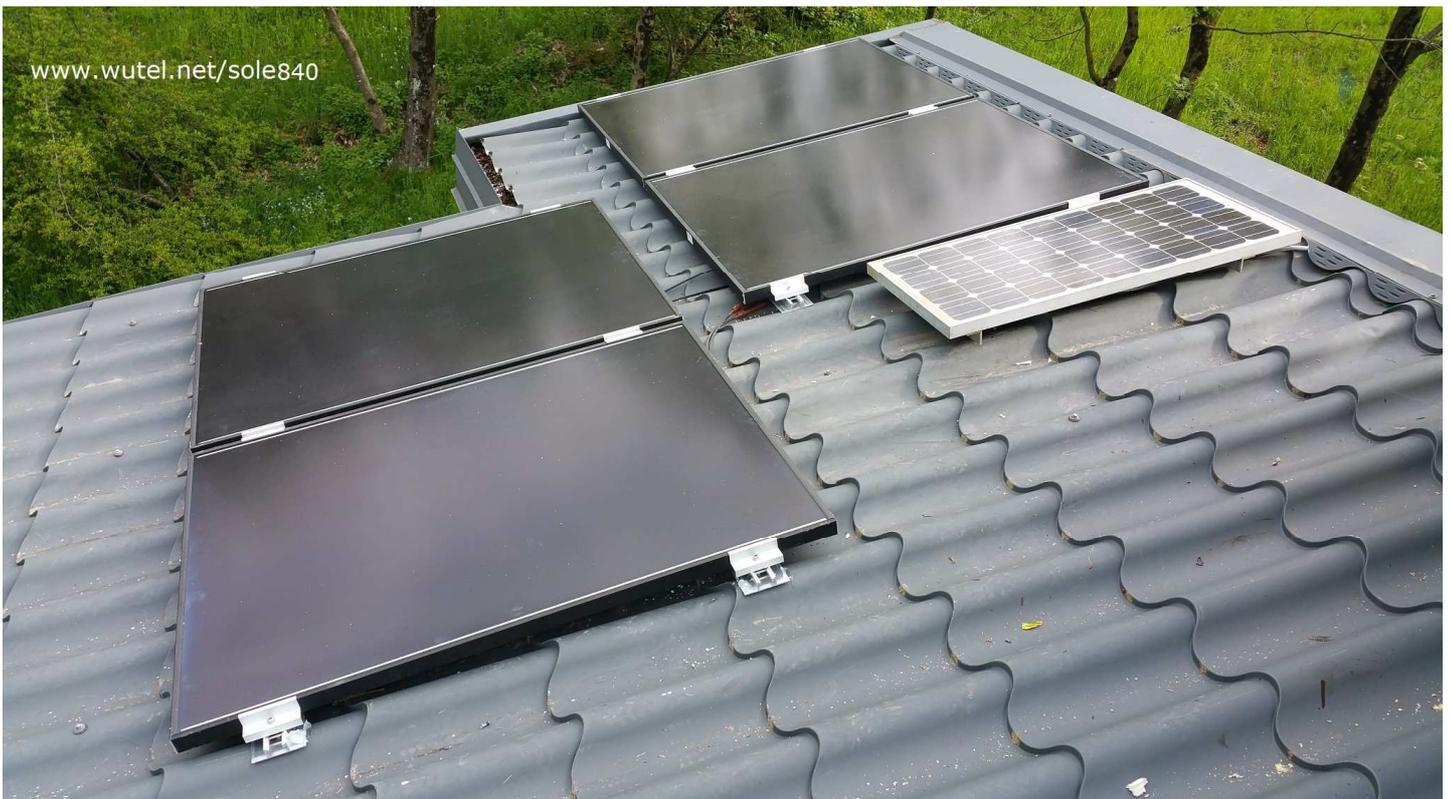
I pannelli CIS sono stati fissati sul tetto coibentato in lamiera della casa, tramite delle apposite barre piatte avvitate alla struttura.
