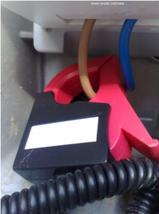
(6) Sensore consumi a pinza amperometrica
